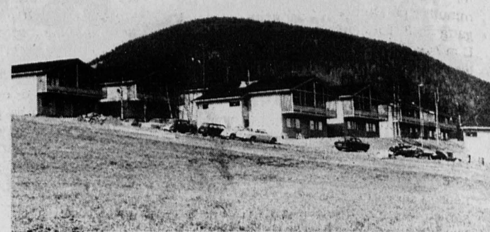
ANDRE BYGGETRINN ved Ekrom-skogen er for lengst i gang, og vil bli fullført i løpet av sommeren. Bildet er tatt fra Øvre Smestad gård — mot nord-øst.
