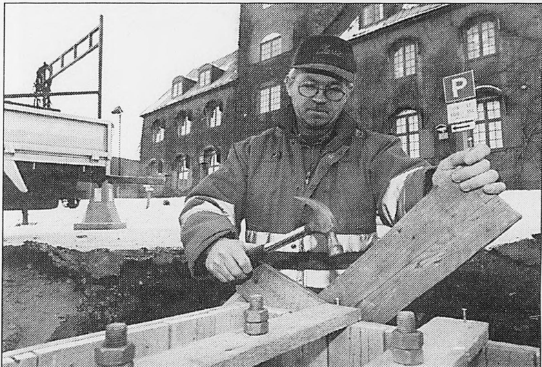
Johnny Hovde og kollegene i teknisk etat bygde i går fundamentet for den nye flaggstanga på Stortorget.
